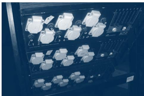
Fig. nº 3. 46 - Uma rack com três racks portáteis analógicas Act6 da STRAND LIGHTING com faders para regular a intensidade de cada dimmer
