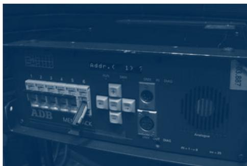
Fig. nº 3. 47 - Rack digital com um visor de cristais líquidos. Nesta imagem, pode-se reparar no acesso rápido aos sistemas de protecção
