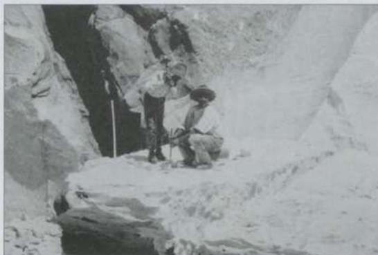
Fig. 13 - Guilhação, método de corte pelo qual os blocos adquiriam a forma rectangular.
