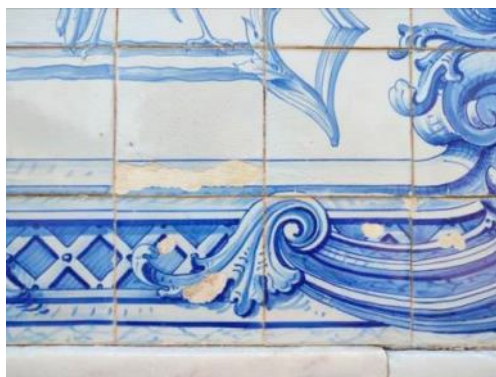
Figura 2 – Pormenor de destacamentos de vidrado, ALD.
