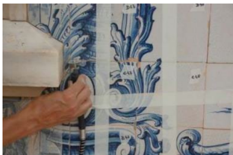
Figura 17 – Infiltração de consolidante, AAP1.
