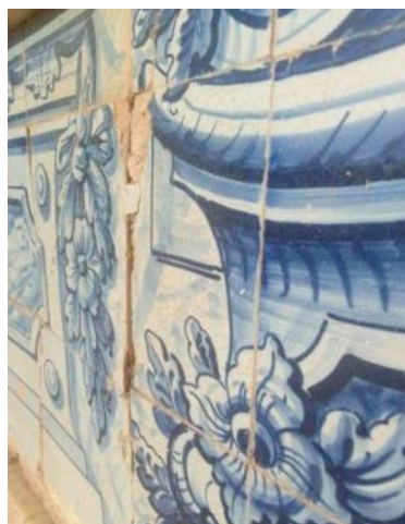
Figura 3 – Pormenor de desagregação da chacota, AAP6.
