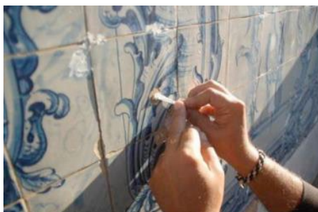
Figura 22 – Pormenor de Aplicação de massas de preenchimento nas lacunas do vitrado, ALE.
