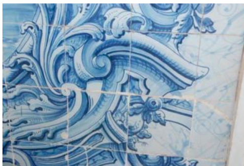
Figura 4 – Pormenor da presença de argamassas de cimento nas juntas, APP5.
