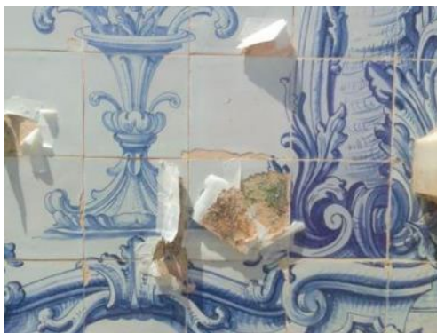
Figura 7 – Pormenor da colonização biológica nas áreas de bolsa e descolamento, AAP1.
