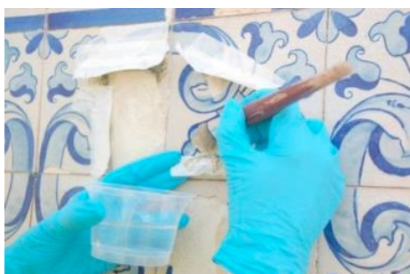
Figura 10 – Pormenor da aplicação de biocida, APR.
