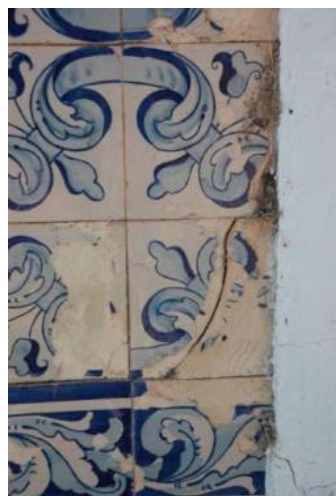
Figura 5 – Pormenor de fratura e perda significativa de vidroado, ALER.
