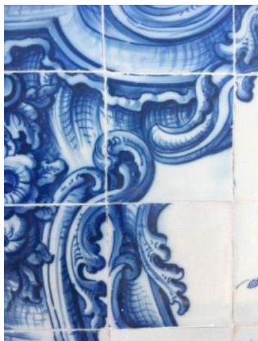
Figura 6 – Assentamento errado no painel, AAP6.
