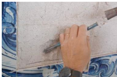
Figura 15 – Remoção de argamassas não funcionais nas áreas de levantamento de azulejos, APP2.
