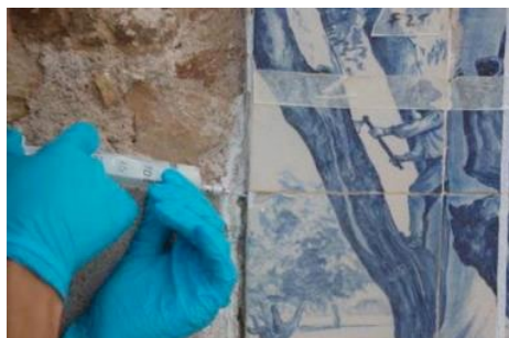
Figura 16 – Pormenor de abertura de juntas, AAP1.
