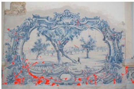
Figura 8 – Mapeamento de lacunas do vidroado, AAP1.
