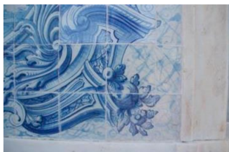
Figura 25 – Pormenor após a reintegração cromática, AAP4.
