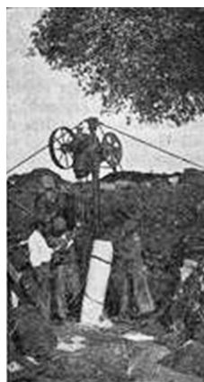
Aspecto de uma pedreira trabalhada pelo fio helicoidal
