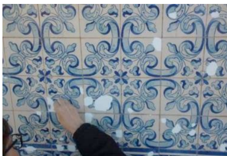
Figura 23 – Pormenor de nivelamento de massas, APR.
