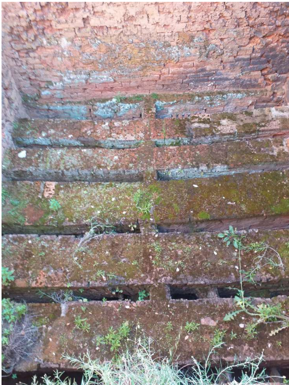
Figura 6 – GRELHA – por cima da abóbada, onde era colocada a telha.
