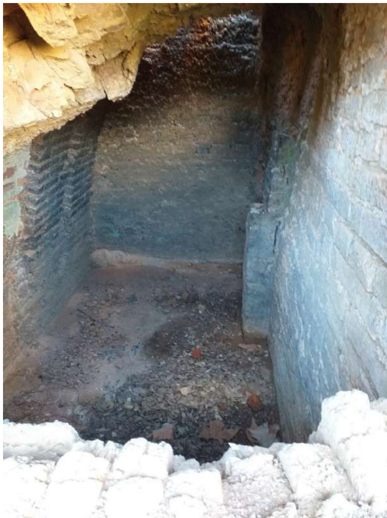
Figura 5 – FORNO – onde era queimada a lenha.
