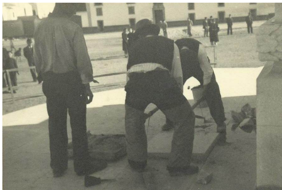
Estátua de D. João IV, colocação da última pedra
