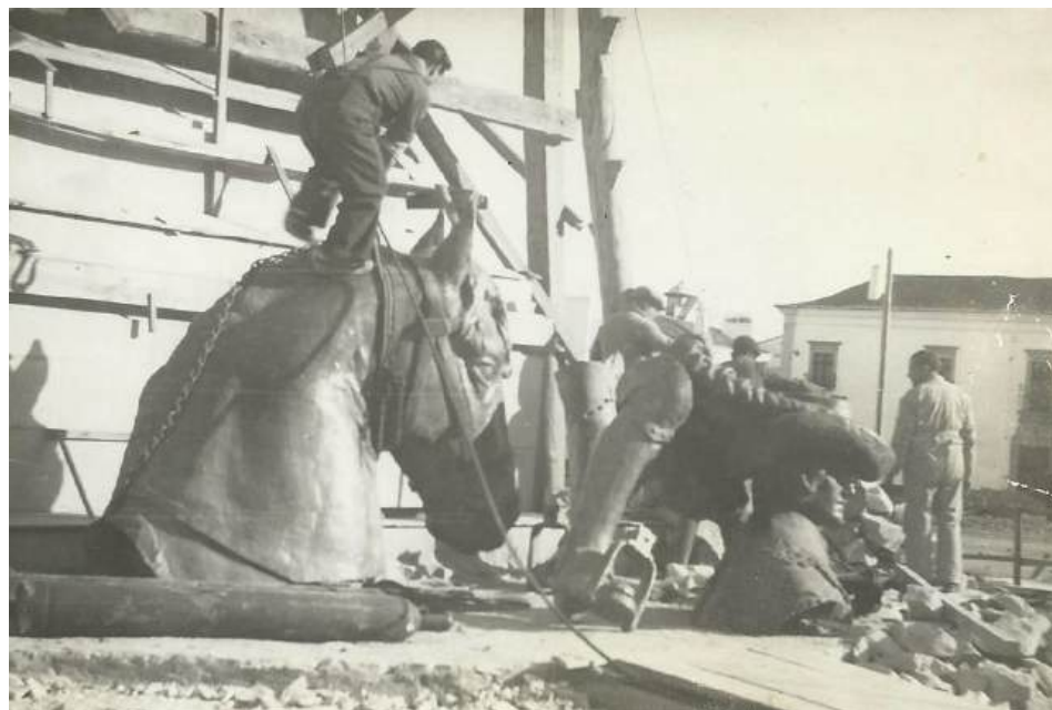
Estátua de D. João IV, trabalhos de construção
