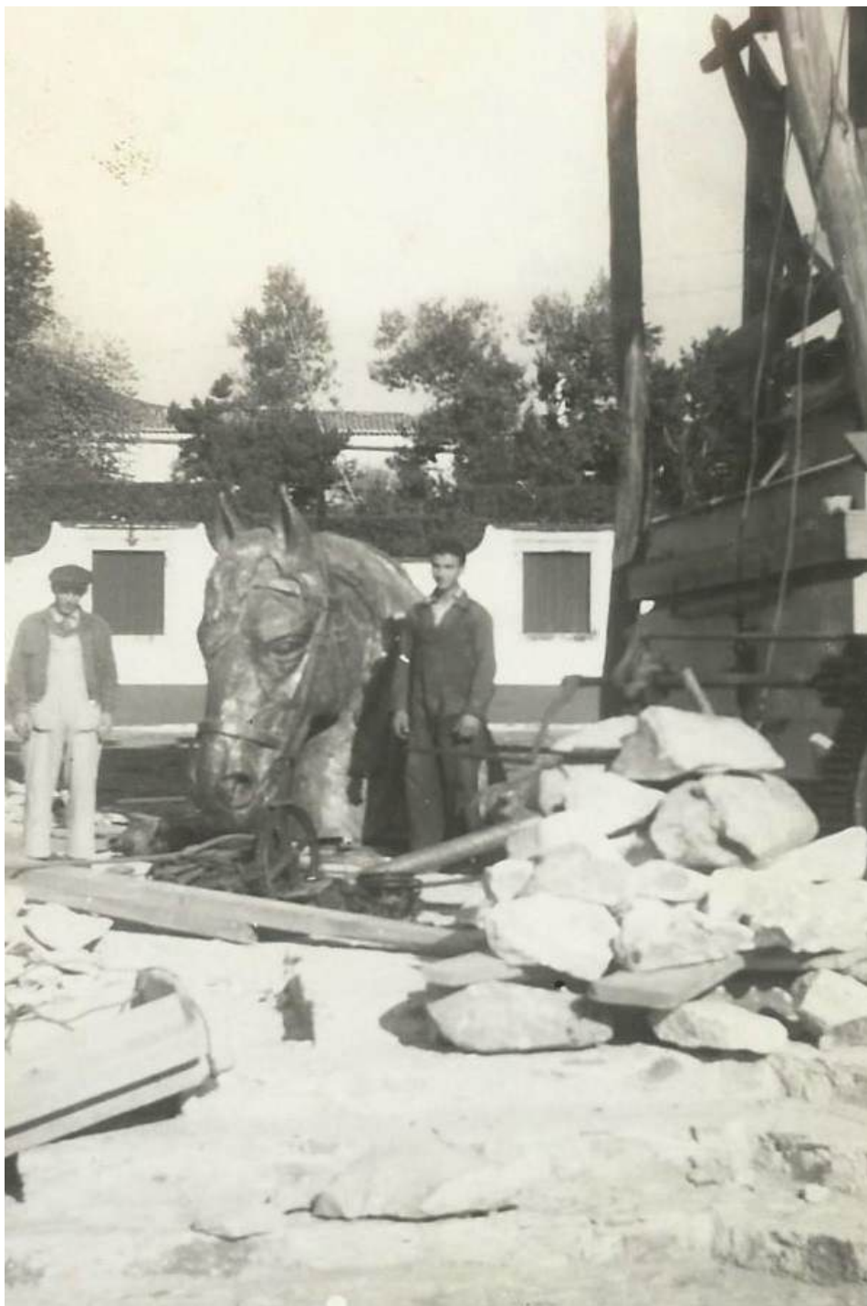
Estátua de D. João IV, trabalhos de construção
