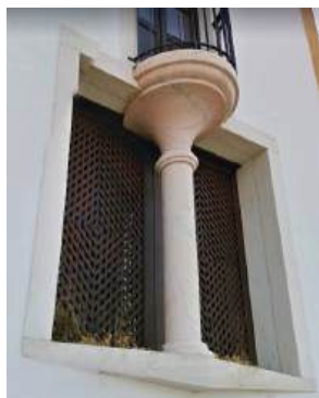
Casa D: Conjunto de janelas, originalmente com quebra-luz em ripas cruzadas de madeira, hoje lamentavelmente em alumínio (assim decaí a escala do gosto).
