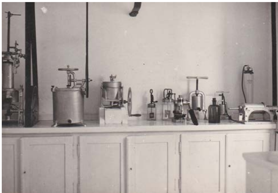
Figura 3 – Laboratório – Área dos preparados oficiais, com destaque para a máquina de encher bisnagas (à esquerda) e as prensas. © Farmácia Monte.
