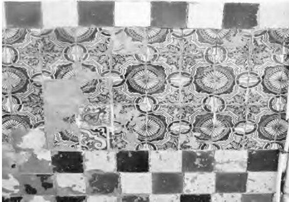
Figura 2 – Imóvel 12-14 do Largo D. João IV.
