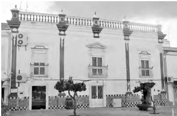
Figura 3 – Revestimento azulejar do rodapé do imóvel 12-14 do Largo D. João IV – No lambril, encontram-se azulejos de três tipos distintos, de xadrezes azuis e brancos e de tapete policromado, de bom desenho seiscentista, provenientes do Convento de Nossa Senhora da Esperança.
