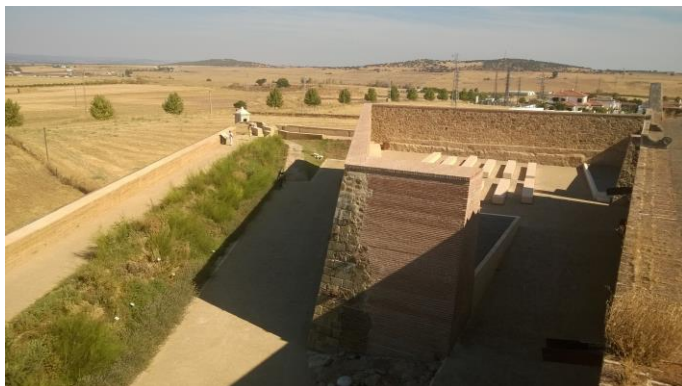
Foto 18. Olivenza. Desacertada recomposición de baluarte y caballero, tras anterior vaciado
