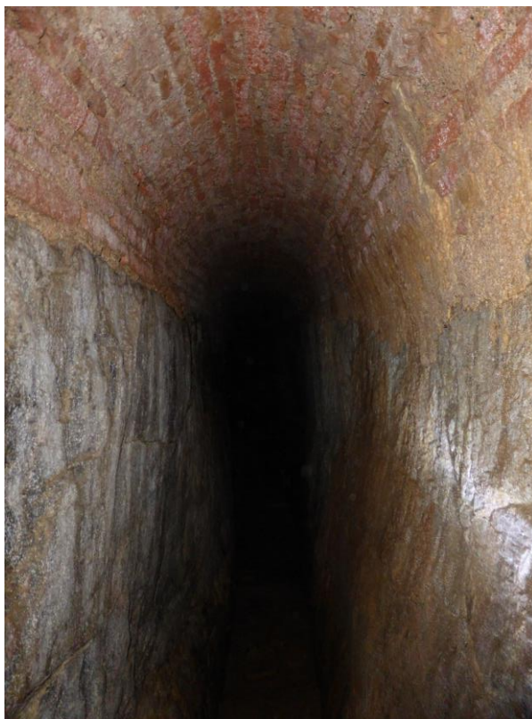
6 – Primeiras imagens do interior do aqueduto (com destaque para o tecto em abóbada de tijoleira – 2, 20 metros de altura)
