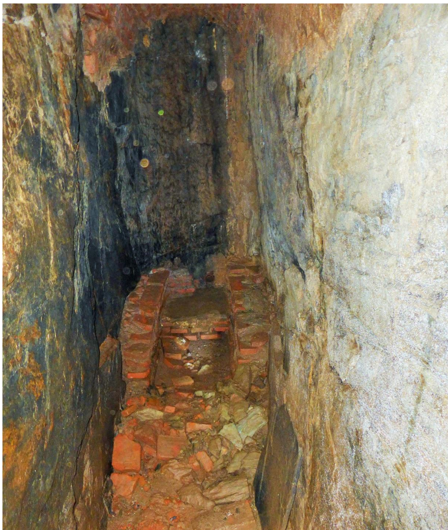
7 – Zona do cano da nascente, ou do canal de escoamento de água, no limite sudoeste do aqueduto, com emparedamento em xisto
