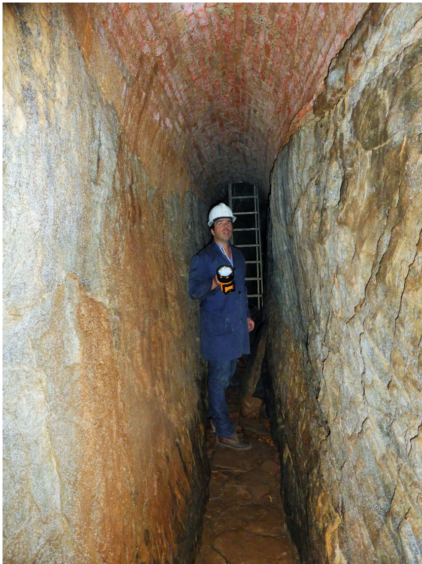
8 – Aspeto geral do teto em abóbada, com paredes de xisto
