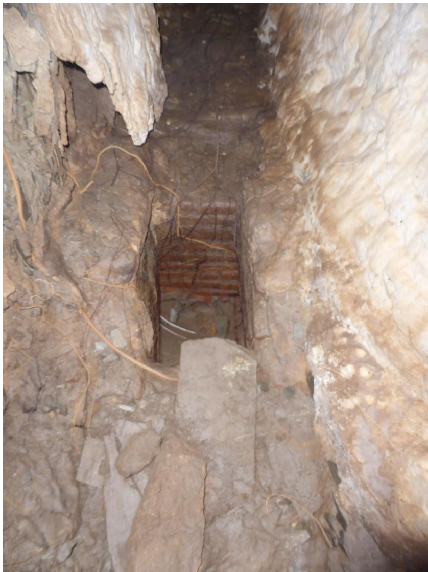
9 – Reservatórios de água existentes ao longo da extensão do aqueduto (caixas de limpeza)
