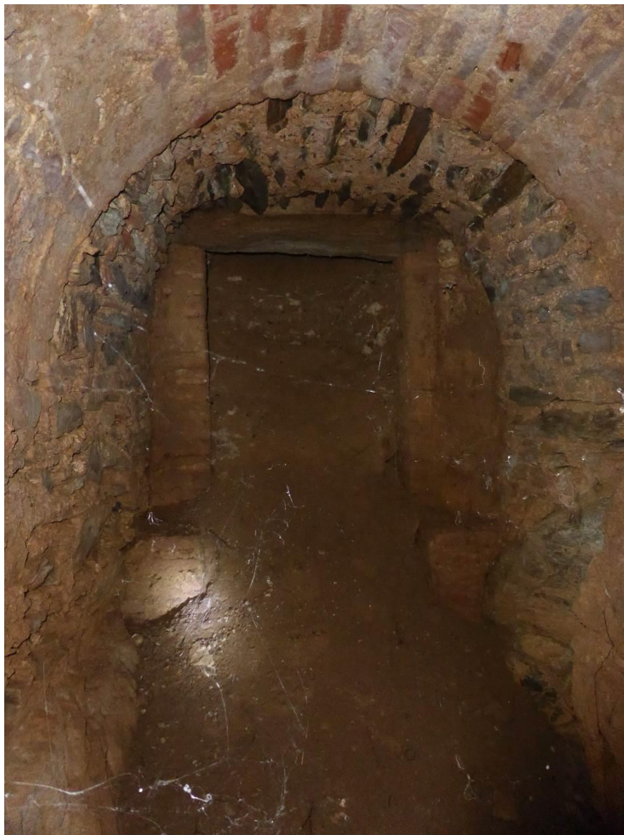
13 – Parte final do aqueduto, a norte, onde se verificou um entaipamento de um pórtico, talvez originado por um deslizamento de terras
