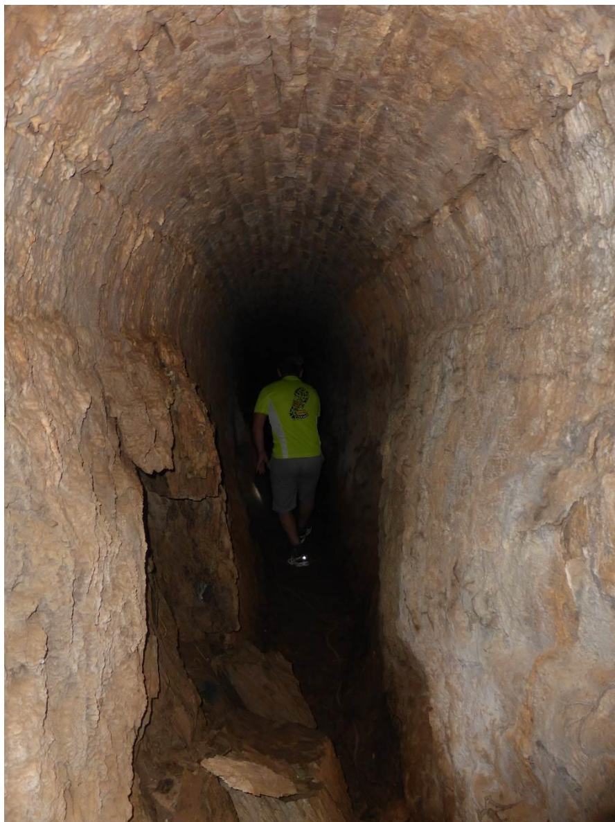
11 – Zona do aqueduto onde se verificaram ruturas na parede de xisto
