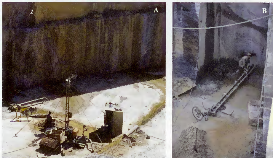
Fig. 7 – A: Montante com poleia, posicionado junto do furo, por onde se faz a entrada na bancada, do fio helicoidal e da areia previamente passada pelo crivo; B: Saída do fio helicoidal na base da bancada sendo direcionado para o exterior. Trabalhos realizados na pedreira da empresa Criadmármore em finais do Século XX.
