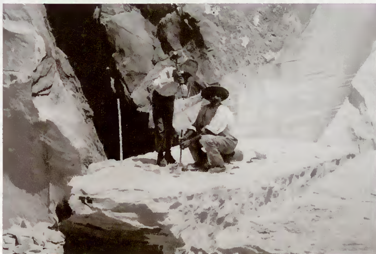
Fig. 4 – Perfuração com escopro e maço. Fonte: foto Solubema, Sociedade Luso Belga de Mármore SA.
