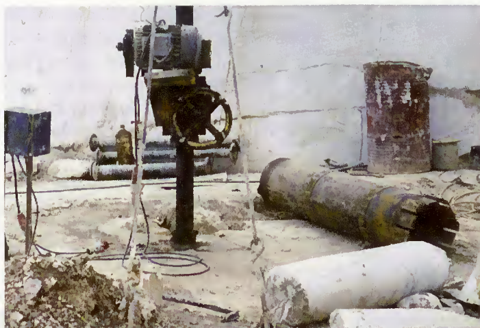
Fig. 8 – Coluna perfuradora, com broca e “nabo” já removidos.
