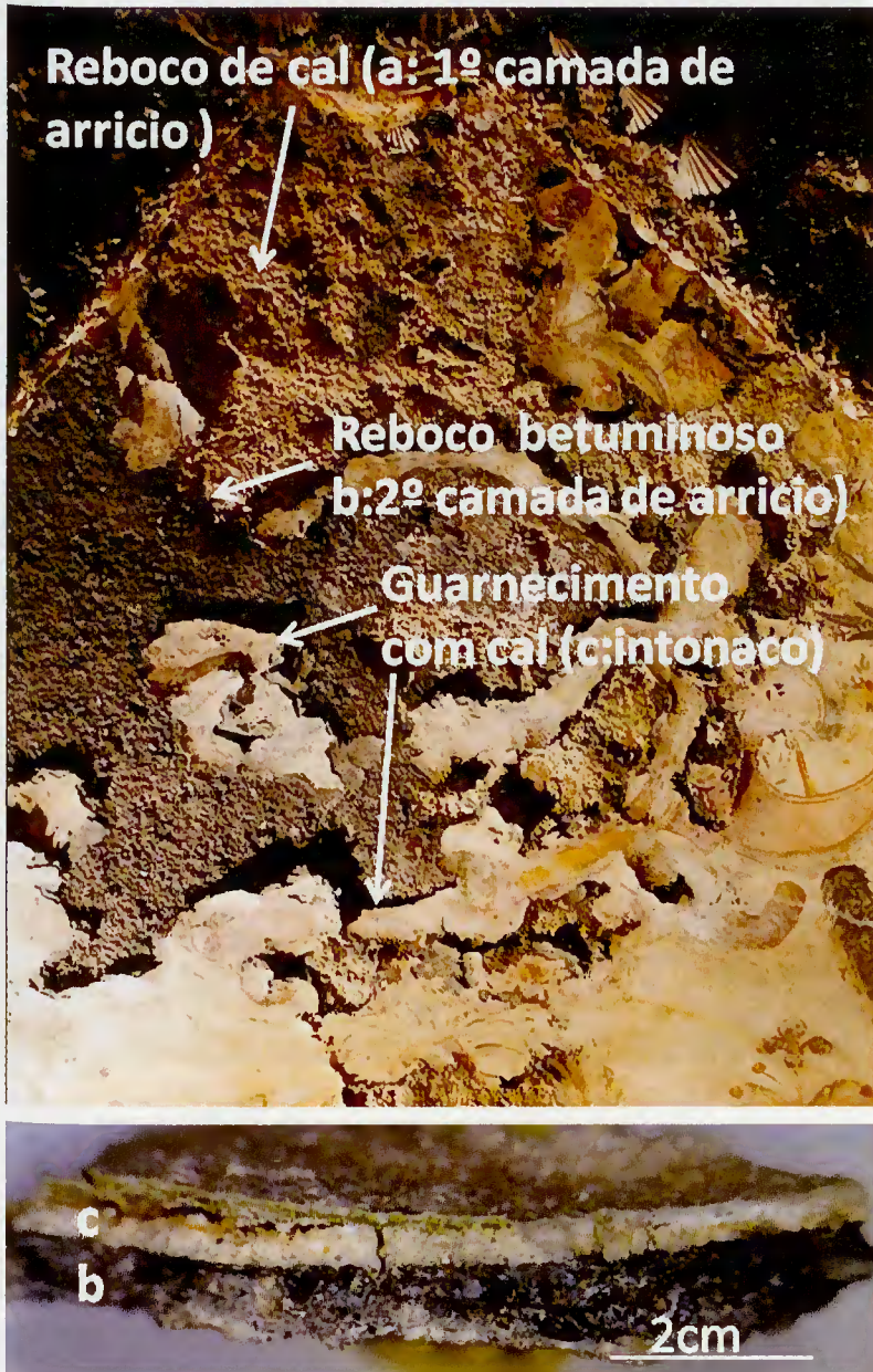
Fig. 8. Estratigrafia das pinturas murais: o material de natureza betuminosa foi adicionado à argamassa de cal e areia da segunda camada de arricio (foto M. Gil2012)
