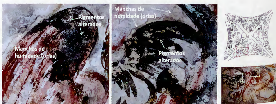
Fig. 4. Pormenor decorativo afetado por alteração cromática e manchas de humidade (foto MGil2011)
