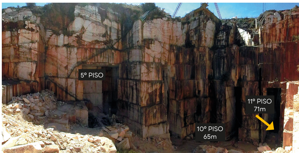
Figura 14 – Pedreira do Texugo, vista geral para sul em 2015.
