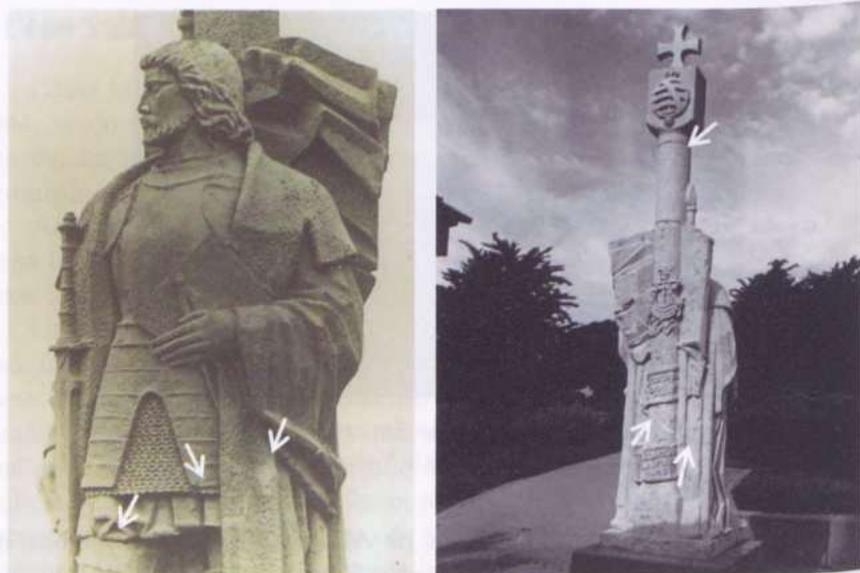
Fig. 3 – Fotografias da estátua original de Cabrilho, revelando profunda alteração da pedra. As setas indicam as zonas onde é mais visível a deterioração da pedra e algumas tentativas de restauro.
